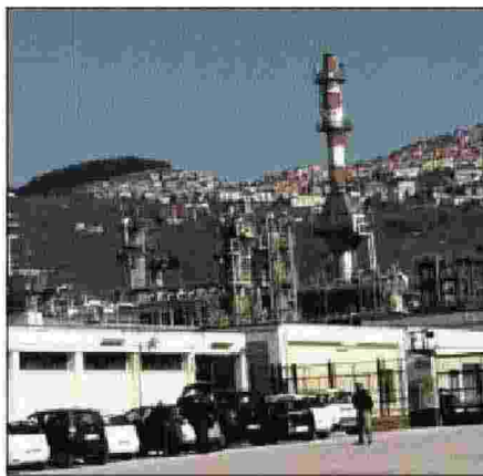
Il Centro olio, sullo sfondo il comune di Viggiano
