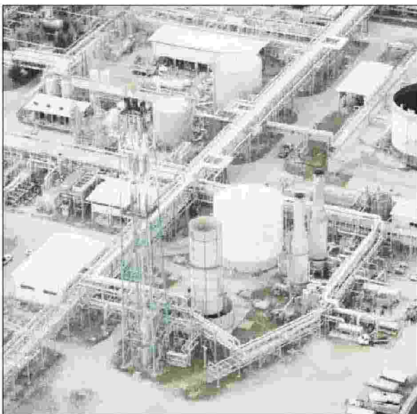
La fiaccola del Centro olio dell'Eni di Viggiano
