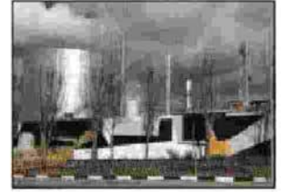
Il Centro olio di Viggiano
